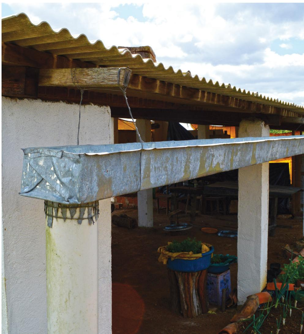
*Calha já instalada para receber a água do telhado*
