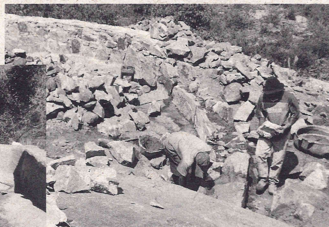
Construção dos muros para juntar mais água
