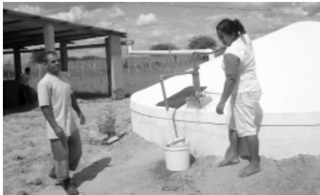
Agricultora Ana Paula já usa água de sua cisterna telhadão
