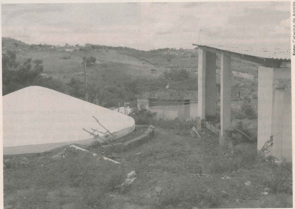
A cisterna telhadão garante reserva de água para os animais e a plantação
