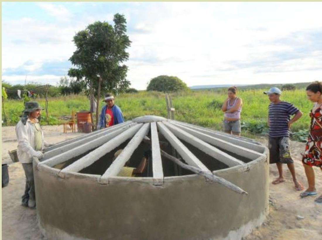
Cisterna de placas: uma tecnologia necessária para estocar água no Semiárido
