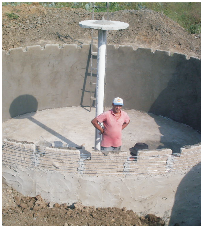
Estão sendo construídas nove cisternas calçadão nas comunidades
