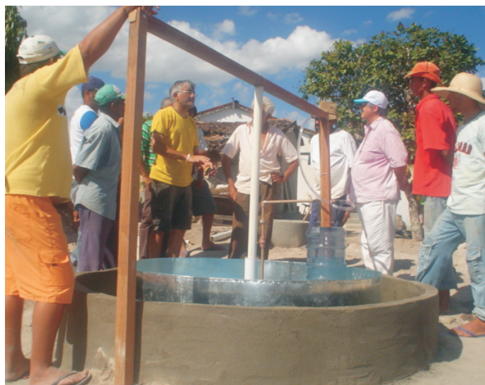
Mutirão de construção do biodigestor da família
