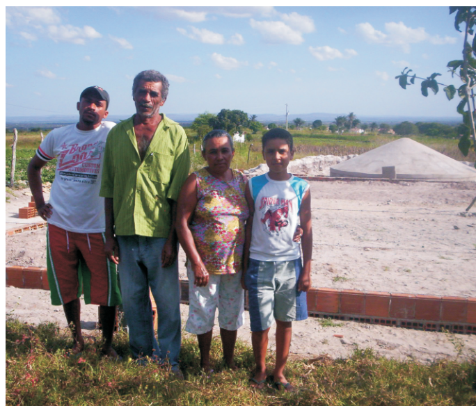
Construção da cisterna calçadão da família
