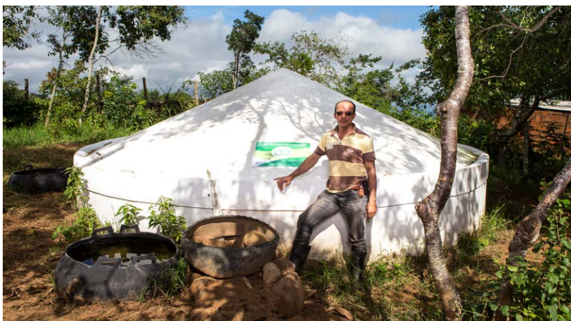
Cisterna de 52m 3 que tem como área de captação um telhado construído para esse fim. Comunidade Baixa das Flores - Santa Cruz da Baixa Verde/PE.
