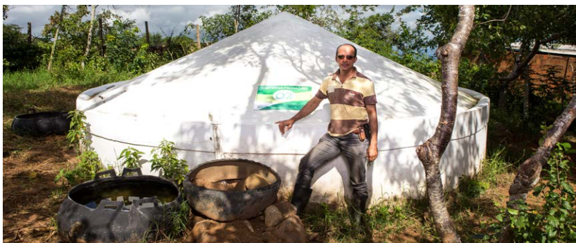
Cisterna de 52m 3 cuya zona de captación es un techo construido para este fin. Comunidade Baixa das Flores - Santa Cruz da Baixa Verde / PE.
