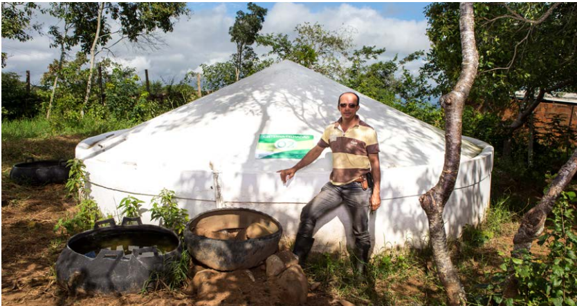
Cistern 52m 3 whose catchment area is a roof built for this purpose. Comunidade Baixa das Flores – Santa Cruz da Baixa Verde / PE.
