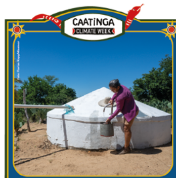
CISTERNA DE PLACAS
