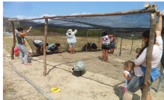
Figura 5 - Oficina para construção de viveiro de mudas: comunidade Gameleira, Itapetim – PE
