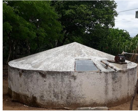
Figura 4: Cisterna concluída Fonte: autoria própria (2020)
