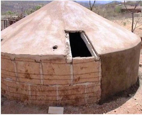
Figura 3: Cisterna em construção. Fonte: Baracuhy, Furtado e Francisco (2017)
