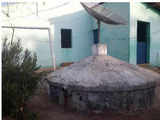
Figura 26: Cisterna 16 mil litros. Fonte: autoria própria (2020)
