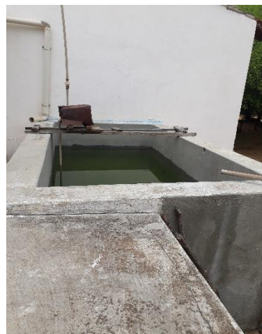
Figura 42: Tanque de alvenaria Fonte: autoria própria (2020)
